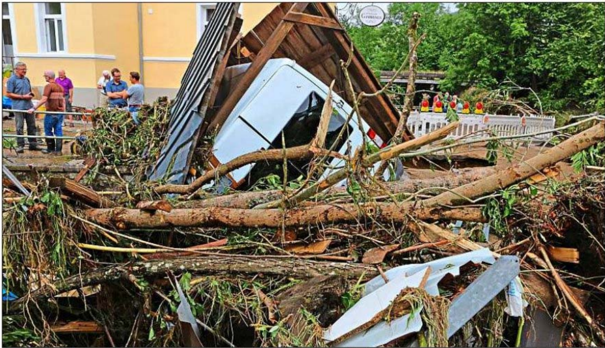
Am Gambrinuskeller wurde ein Auto mit derartiger Wucht in einen Durchlass gepresst, dass es vollständig unter der eingestürzten Brücke im Untergrund verschwand. Obendrauf liegt der Mannschaftsbus der LG Passau mitsamt seinem Carport, in dem er zuvor hundert Meter weiter oben stand. Erst am Sonntagnachmittag konnten Taucher der Wasserwacht das Wrack im Durchlass sichten und melden, dass niemand drin saß. Um behelfsmäßig eine neue Brücke zu bauen, holte das THW Passau Spezialisten aus Freising hinzu. Der Brückenschlag kann aber erst in diesen Tagen erfolgen.
